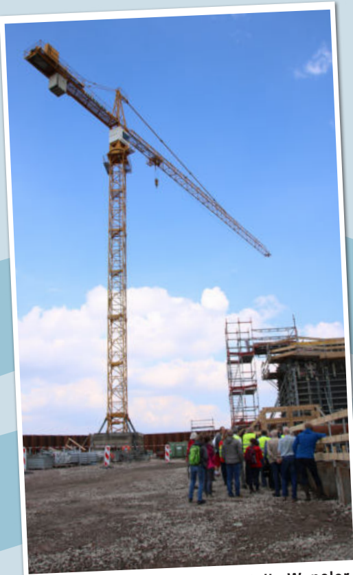
Besichtigung der Großbaustelle Wapeler Siel, ...
