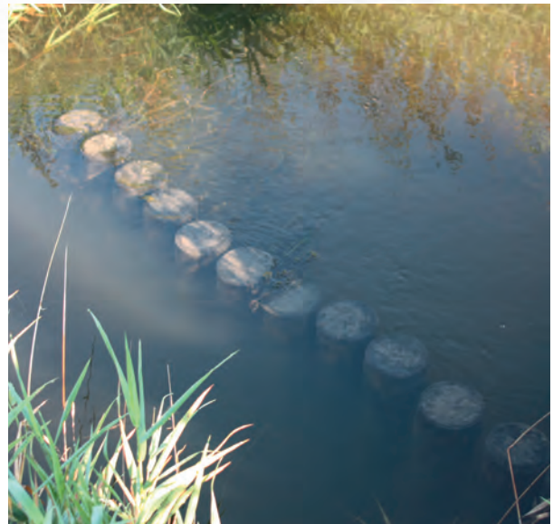
Bei Mittel- und Niedrigwasser wird durch die Einengung die Schleppkraft des Gewässers erhöht – bei Hochwasserereignissen kommt es zu Überströmung
