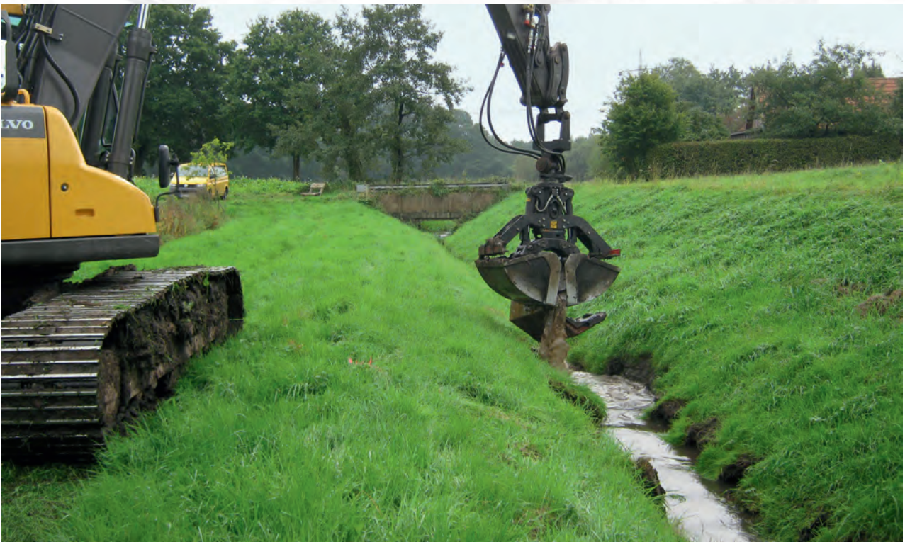
Mit dem Bagger wurden die Betonhalbschalen entfernt
