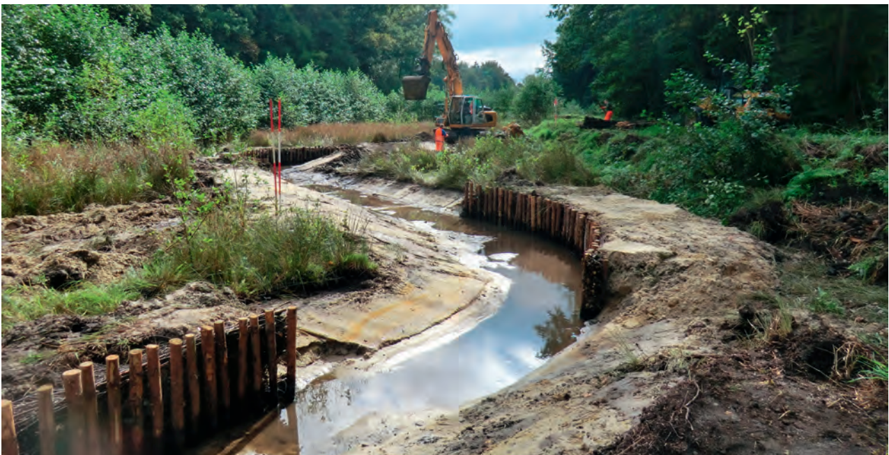
Einbau temporärer Reisigfaschinen, damit sich die zum Teil weichen ehemaligen Teichsohlen verfestigen können.
