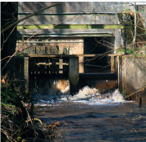
Ein Dammbalkenwehr am Liethbach verhindert die Durchgängigkeit
