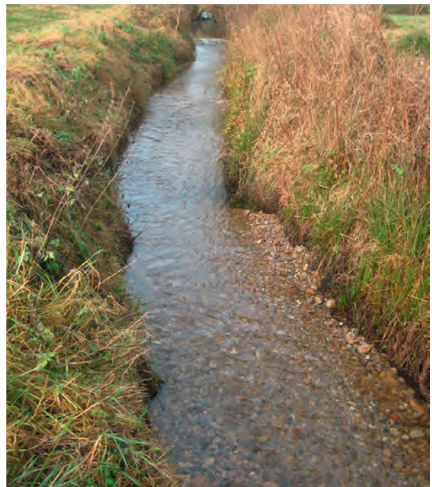
Die naturnahe Sohlgleite fördert die ökologische Durchgängigkeit und bildet wichtige Laichhabitats im Mühlenbach
