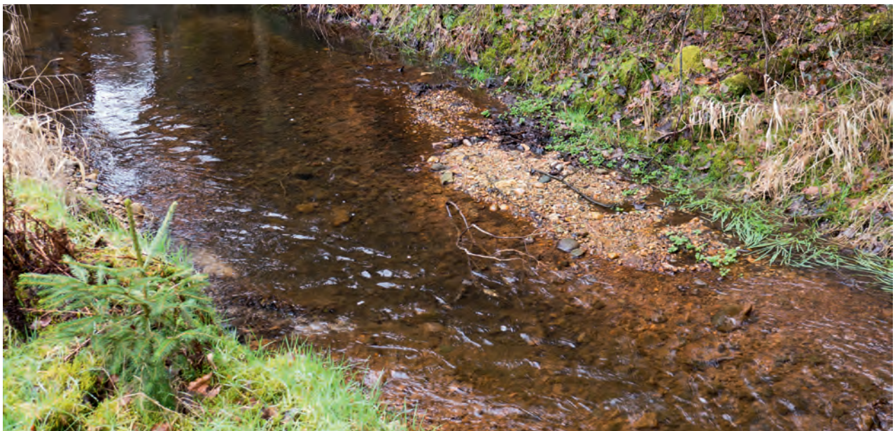
Einengung des Gewässers durch Kieseinbauten erhöht die Schlappkraft (Foto: Manfred Rathgeber)
