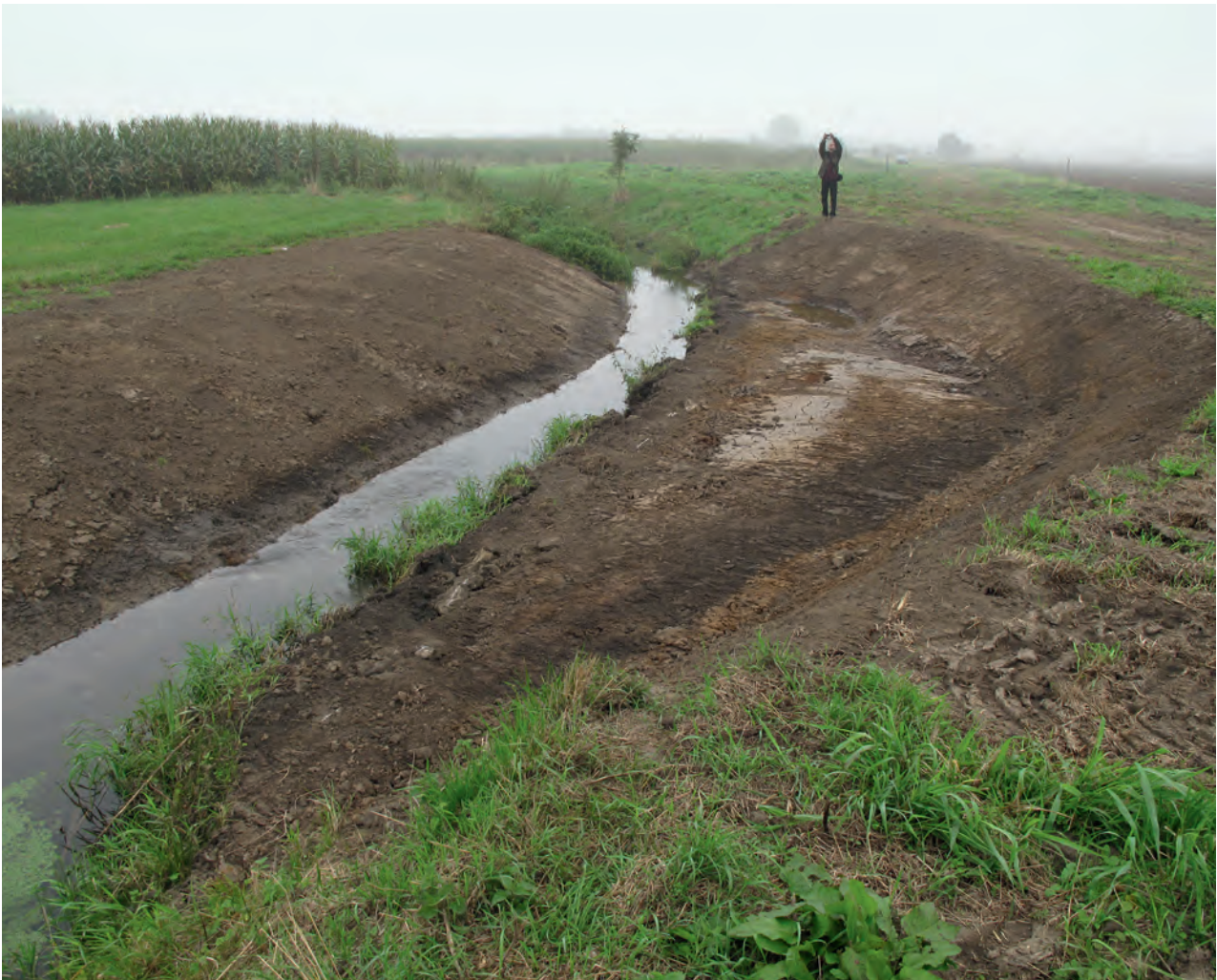
Aufweitung, die zusätzlichen Retentionsraum bietet
