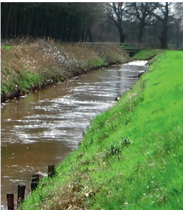
Treibselfang erhöht die Strömungsdiversität
