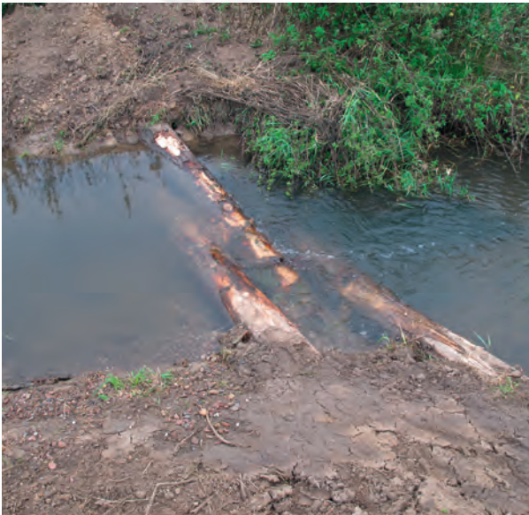
Unter- und überströmte Totholzeinbauten über die gesamte Gewässerbreite: Mut beim Ausprobieren
