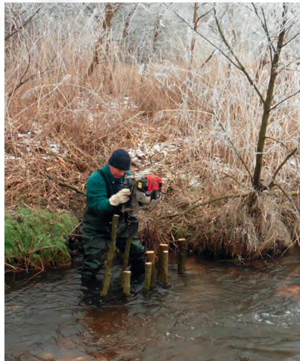
Pfahlreihe zur späteren Fixierung von Totholz
