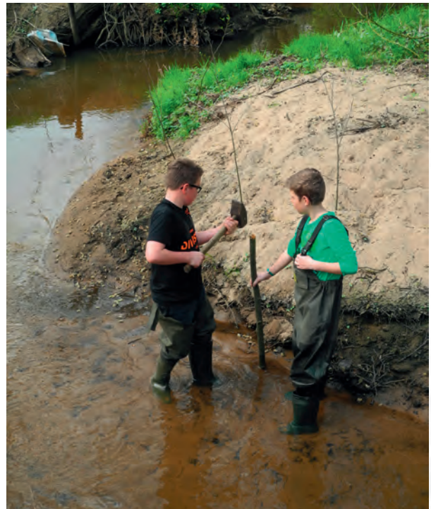
Stabilisierung von Anlandungsbereichen
