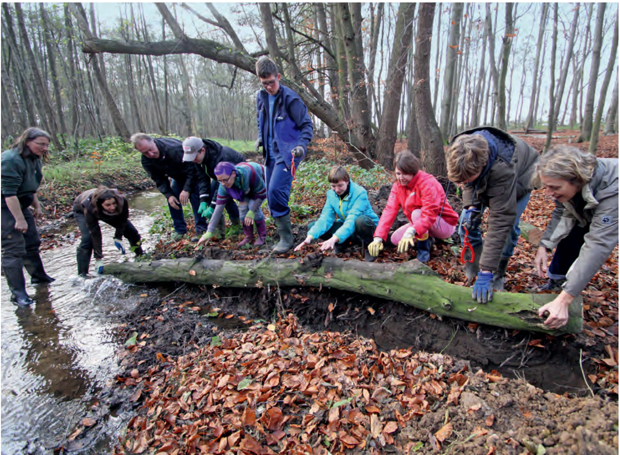
Ein Strömungsenker wird in den Sandbach eingebracht
