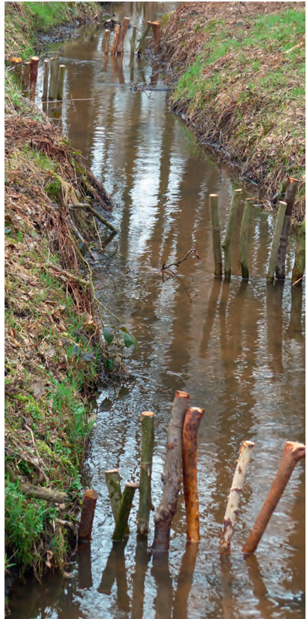
Einengungen durch Treibselfänger: Erhöhung der Schleppkraft des Gewässers
