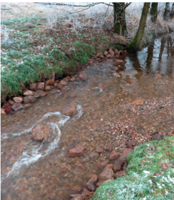
Kieseinbringung auf Lesesteinebasis sowie Lesesteine zur Ufersicherung
