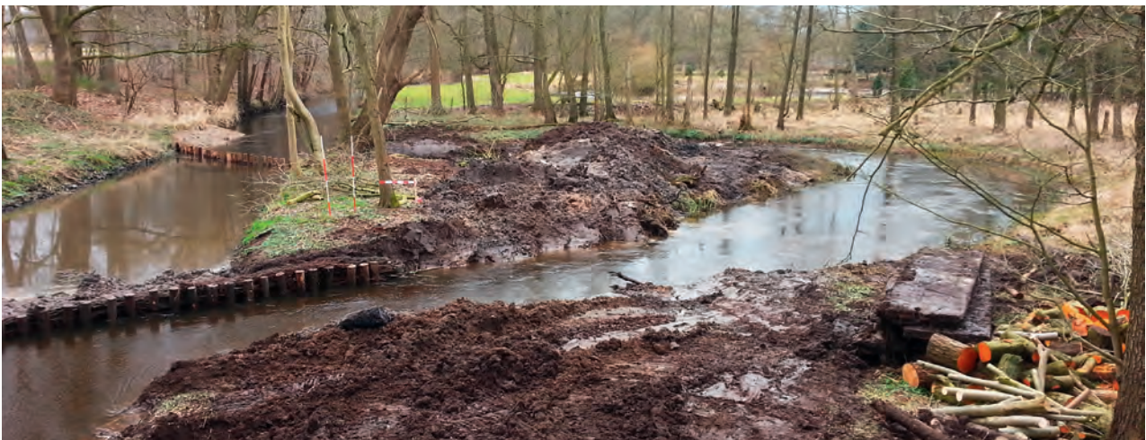
Anschluss des Altverlaufes an der Lachte
