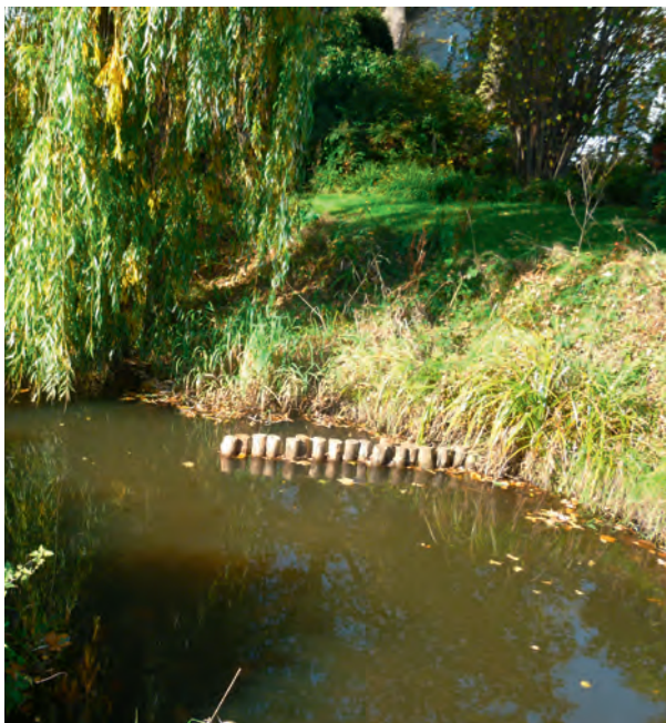
Treibselfänger erhöht die Strömungsdiversität
