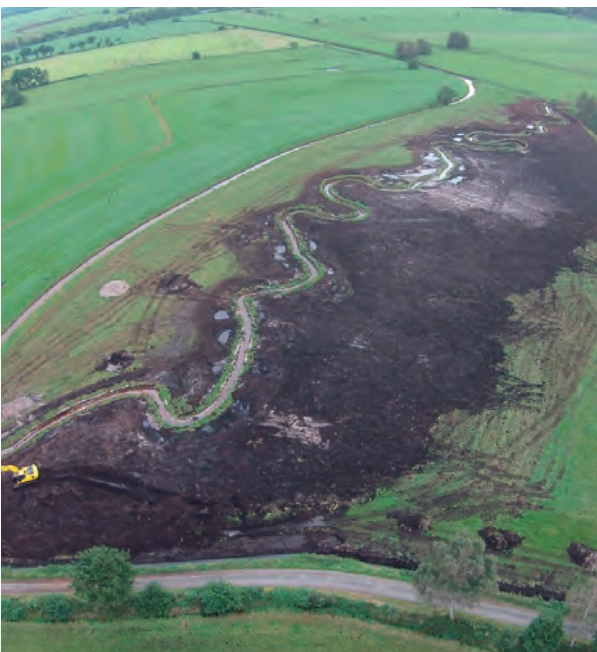
Luftaufnahme des oberen Abschnittes in der Bauphase
