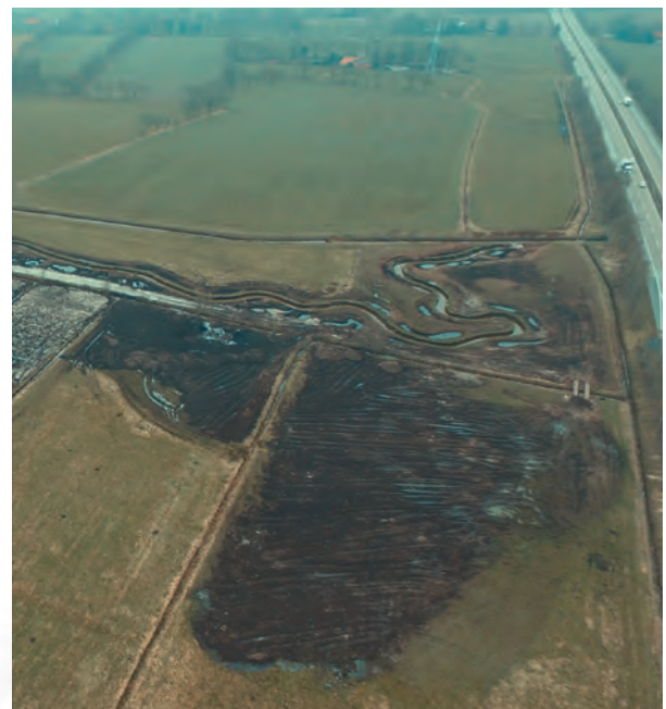
Luftaufnahme des unteren Abschnittes in der Bauphase
