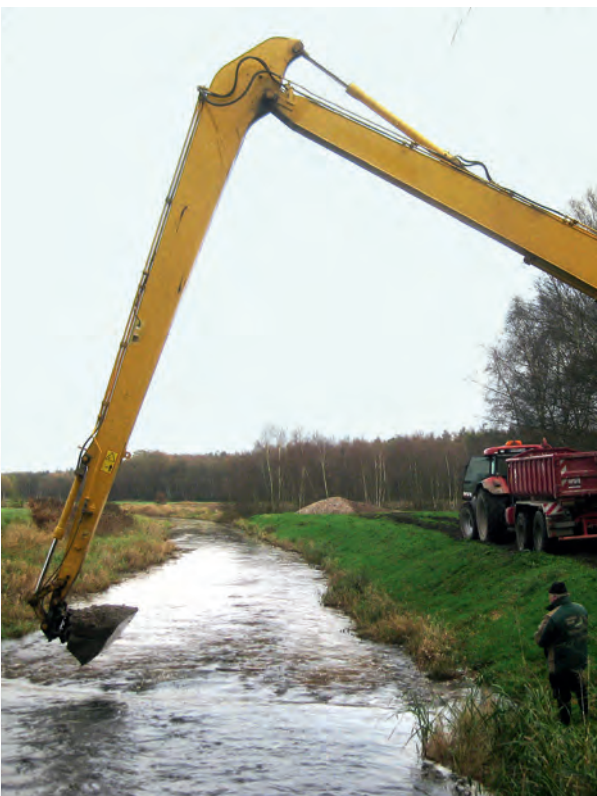
Einbau von Kies mit großem Gerät
