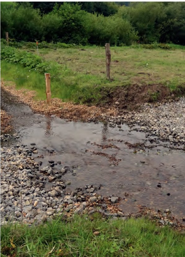
Eine Furt ersetzt den Durchlass.
