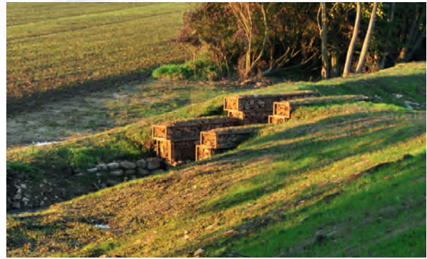
Drosselbauwerk von bachabwärts betrachtet, um Grünland- und Biotopflächen als Retentionsfläche bei starken Niederschlagsereignissen zu nutzen
