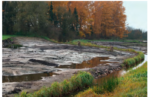
Moorbach mit abgesenkter Gewässerböschung
