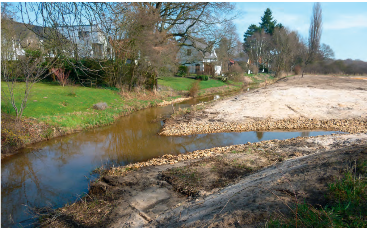
Einmündung der Flutmulde im Bereich Teichwiesen
