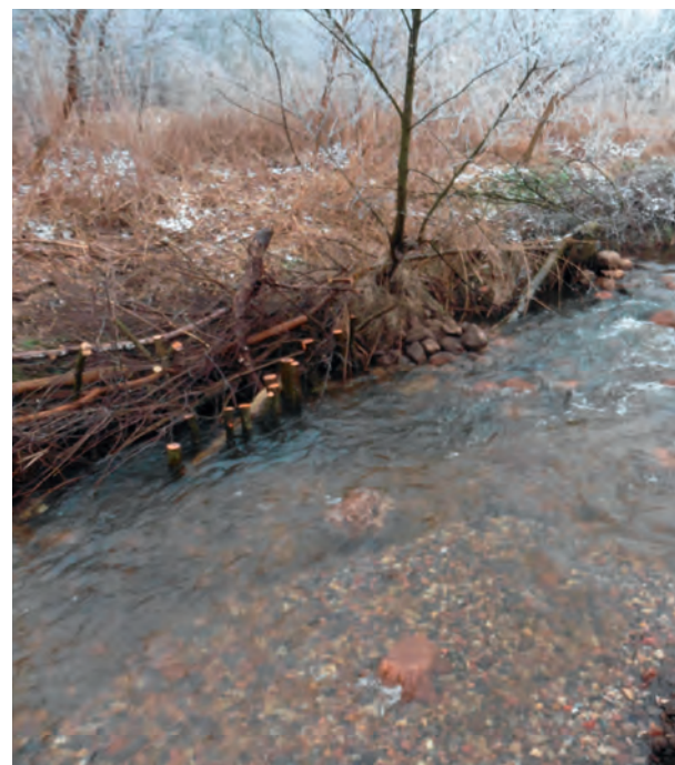
Kies auf Lesesteinebasis sowie Böschungssicherung durch Lesesteine und Totholz
