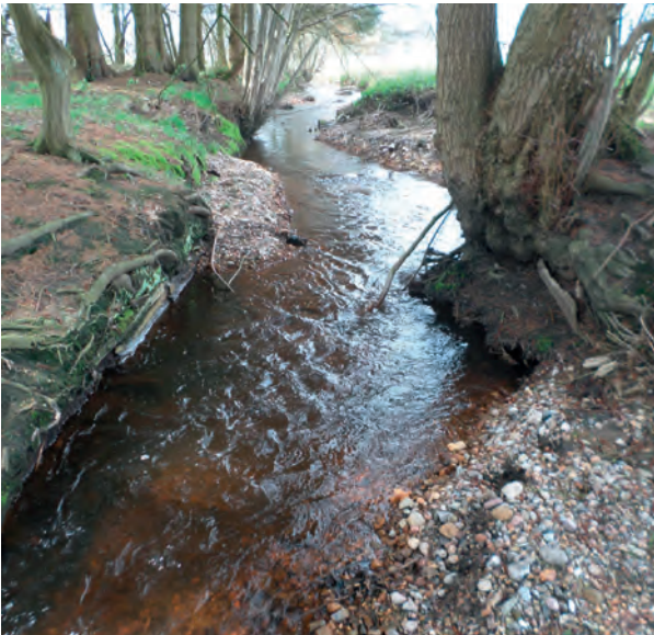
Mit Strömunglenkern und Kolk-Rausche-Sequenzen wurde der Neue Bach durch den UHV naturnah gestaltet
