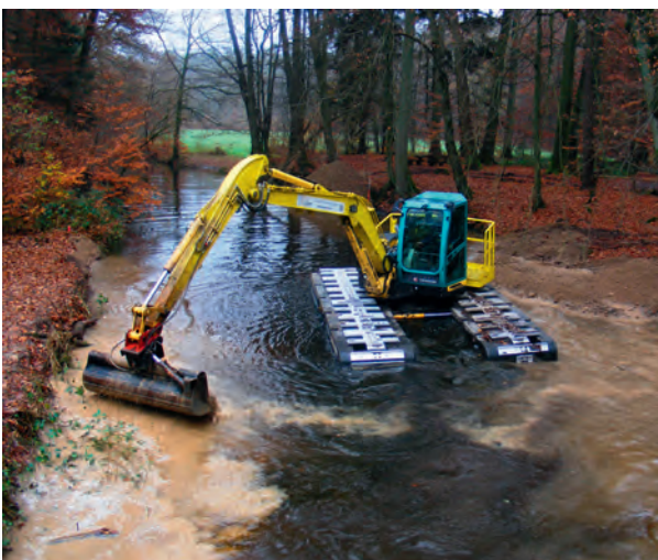
Kieseinbau mit schwimmfähigem Kettenbagger
