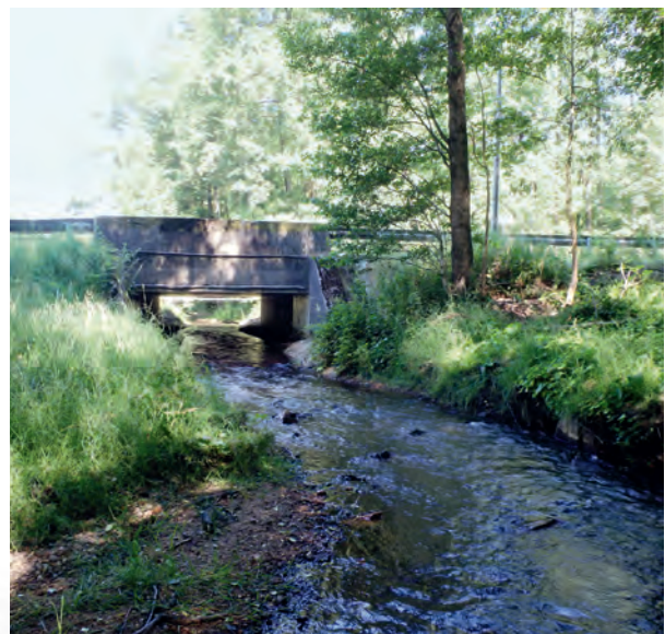
Abbruch des Wehres und Herstellen einer Sohlgleite mit standorttypischem Heidekies
