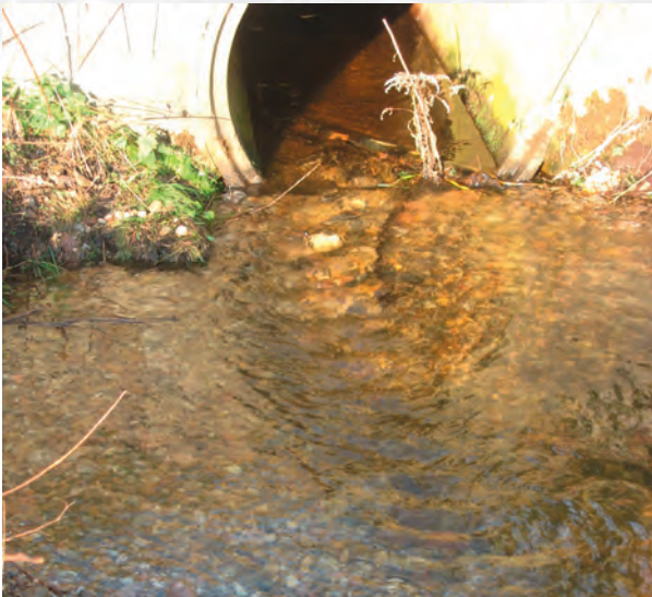
Aufwertung einer der beiden Rohrdurchlässe durch den ASC Sülze e. V.
