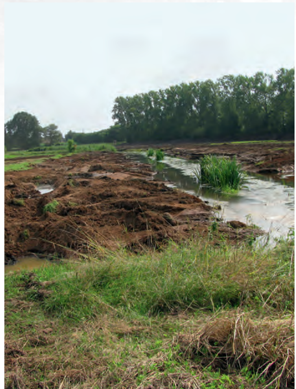
Kraterlandschaft mit Gewässeraufweitung, während der Bauphase
