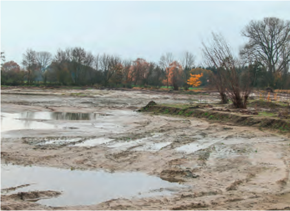
Anlage einer Sekundäraue
