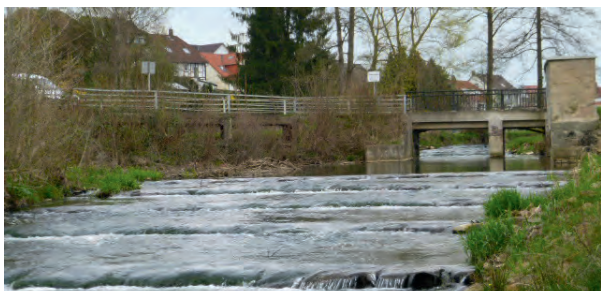
Die Durchgängigkeit wurde durch Einbau eines Steinschwellenbeckenpasses wieder hergestellt.
