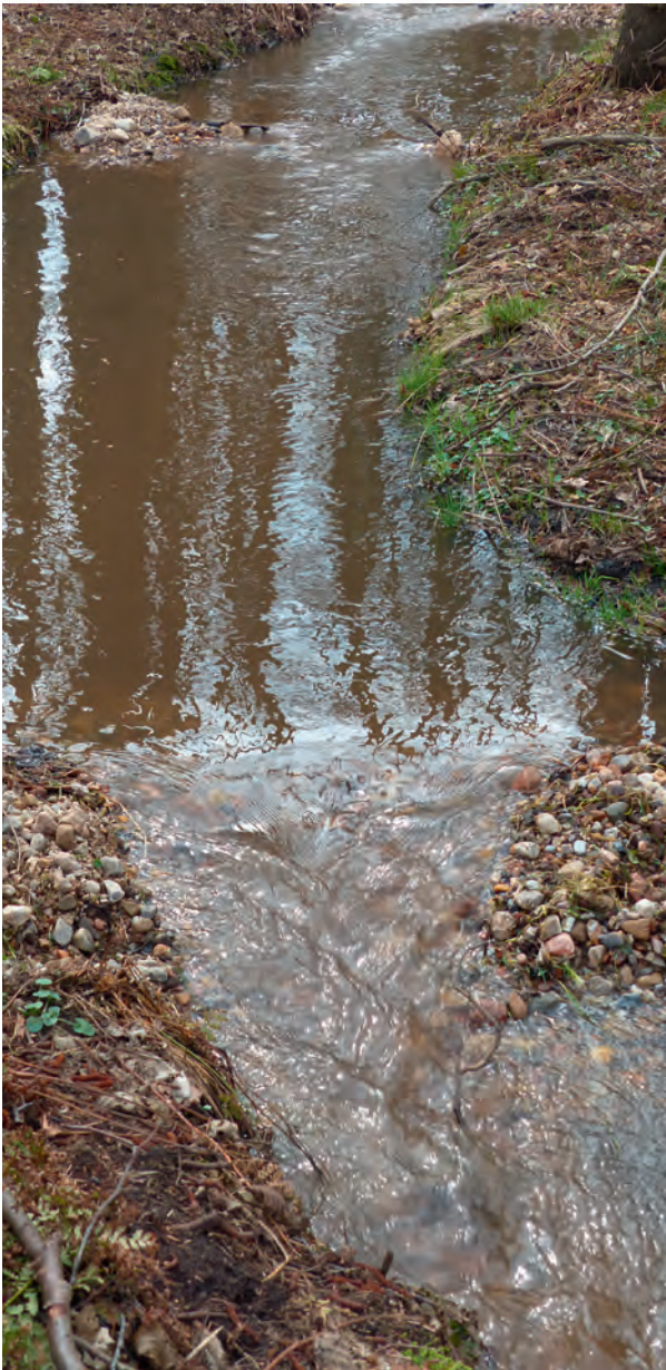
Verbesserte Strömungsdiversität nach dem Kieseinbau
